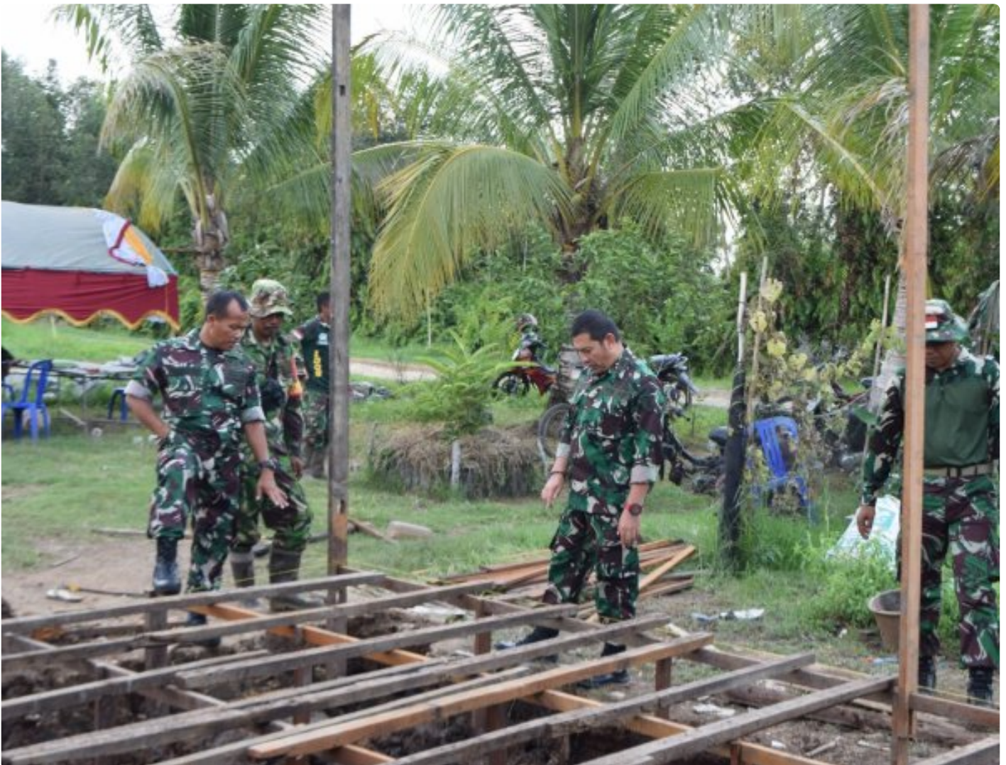
Dandim 1005/Barito Kuala Tinjau Langsung Pelaksanaan Bedah Rumah Tidak Layak Huni (RTLH)
